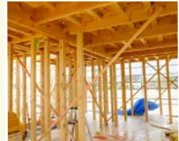
太い柱、幅広の筋交、梁や根太の間隔等、強度UPを図る仕様に加え、職人の技術と適切な施工で、耐震等級最高ランクの等級3相当を標準とした地震に強く安心して暮らせる家づくりを行っています。
