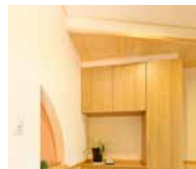
檜の羽目板天井をアクセントに 折り上げた遊び心のある玄関ホール
