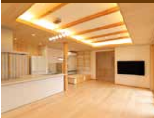
構造梁と間接照明で オシャレな飾り天井
