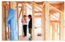
断熱材の施工前は、柱や金物、筋交いなど、どんな材料をどのように施工してい
