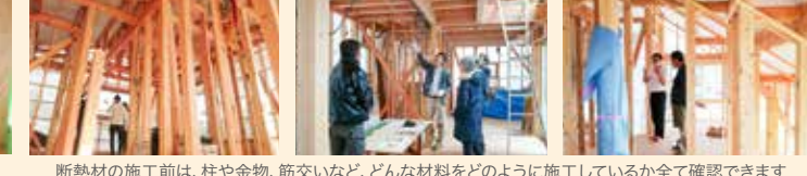
断熱材の施工前は、柱や金物、筋交いなど、どんな材料をどのように施工しているか全て確認できます
